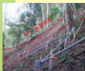
道路斜面変状モニタリング
